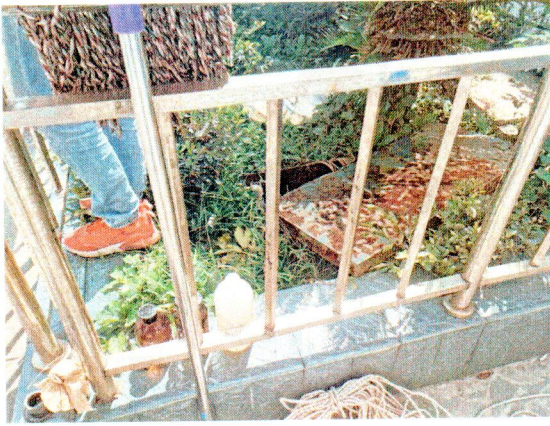
生活污水排口 (★1)
