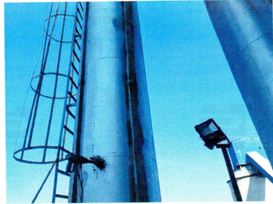
1#线煤磨排气筒 (◎3)
